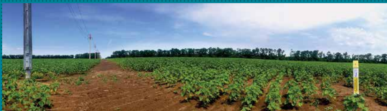
ПКМ-ТСТ-УЗТ на участке Березанского ЛПУМГ
