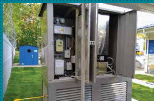
ПЭКЗ с питанием от термоэлектрогенератора
