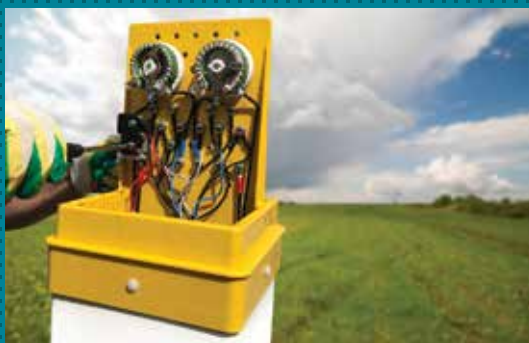
Монтаж кабелей на клеммной панели
