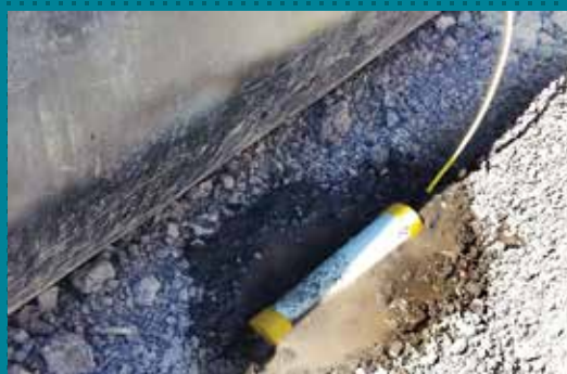
Монтаж электрода сравнения
